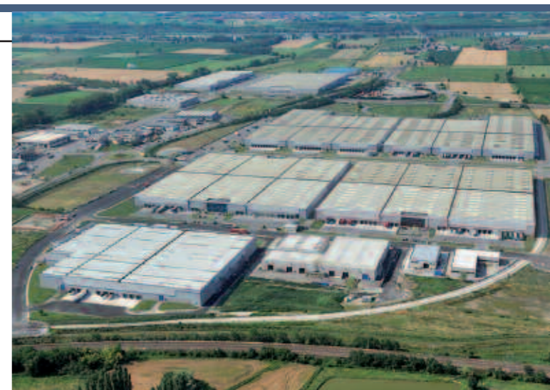
VEDUTA DEL PARCO LOGISTICO DI CASTEL SAN GIOVANNI
