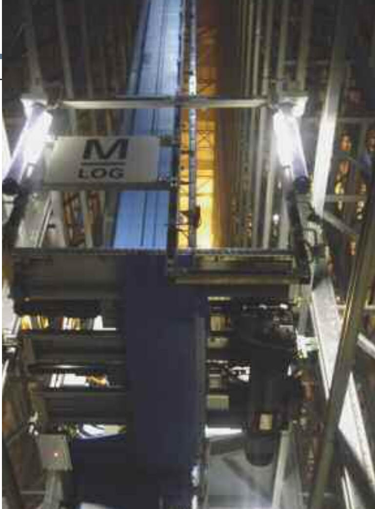
ALCUNI PARTICOLARI DEL SISTEMA AUTOMATICO SERVITO MEDIANTE 4 TRASLOELEVATORI
