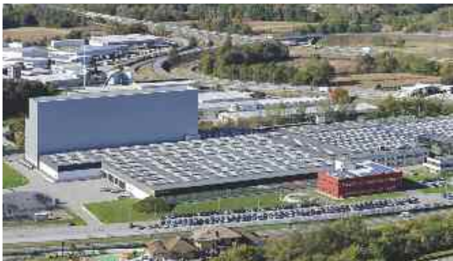
VEDUTA GENERALE DELL'IMPIANTO CALEFFI A FONTANETO (NOVARA)
