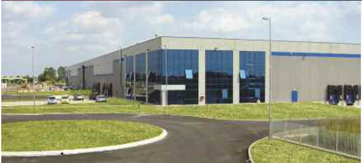
Arqua Polesine (RO). Realizzazione del General Contractor Engineering 2K S.p.A.
