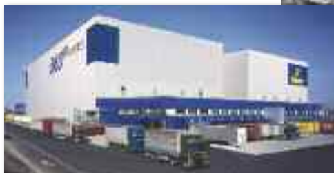
A DESTRA, IL SISTEMA AUTOMATIZZATO DI SCARICAMENTO E CONVOGLIAMENTO CARTONI. SOPRA, VEDUTA DEL DEPOSITO CENTRALE EUROPEO DI TCHIBO A BREMA
