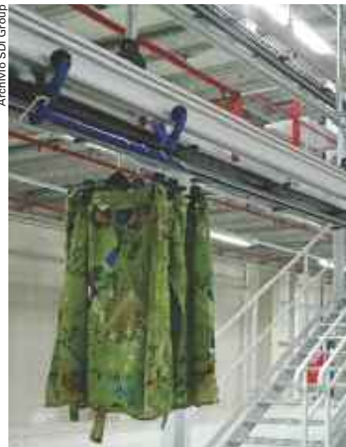
Particolare di un centro di distribuzione realizzato da SDI Group
