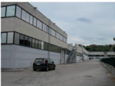
Vista dal piazzale interno
