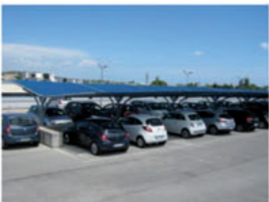
Vista dai parcheggi sopraelevati
