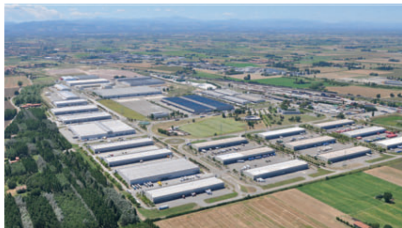
Veduta aerea dell'interporto di Bologna
