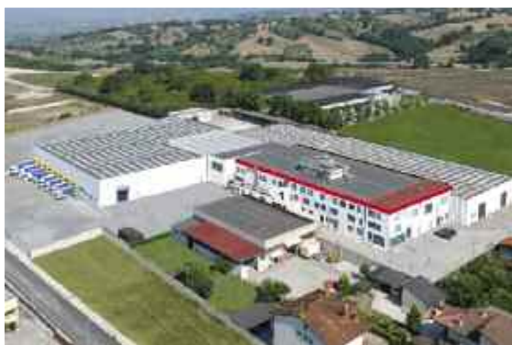
Veduta aerea dell'impianto della Fratelli Vitale a Mirabella Eclano, Avellino
