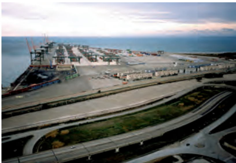
Veduta del Taranto container terminal. Evergreen e Hutchinson, le due società armatrici che l'avevano in concessione lo hanno "restituito" all'Autorità portuale
