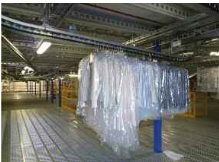
Particolari del sistema automatizzato per la gestione dei capi appesi
