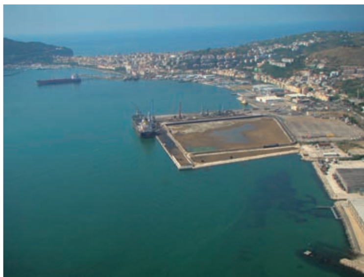
Veduta aerea del porto di Gaeta
