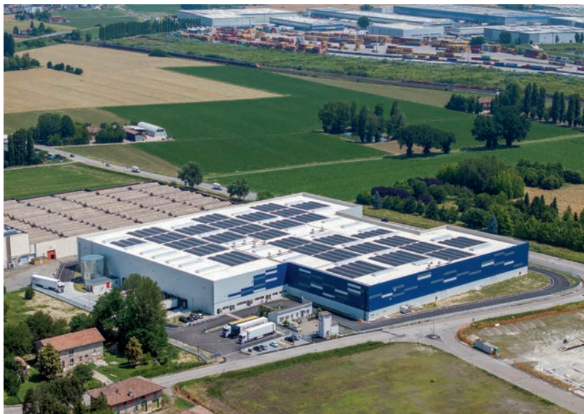
Veduta aerea dell'impianto Logikor a San Giorgio di Piano, nel bolognese. "Si è trattato di un progetto molto complesso e - come spesso accade - più le cose sono complesse e più, una volta portate a termine, danno un forte senso di soddisfazione", ha dichiarato il country manager Italia
