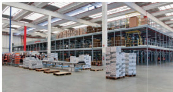
In Italia, la Zalando opera con la piattaforma logistica di Stradella (nella foto), vicino Milano, che è stato ampliato fino a 40 mila metri quadri. E' in costruzione anche un impianto di 130 mila mq vicino Verona
