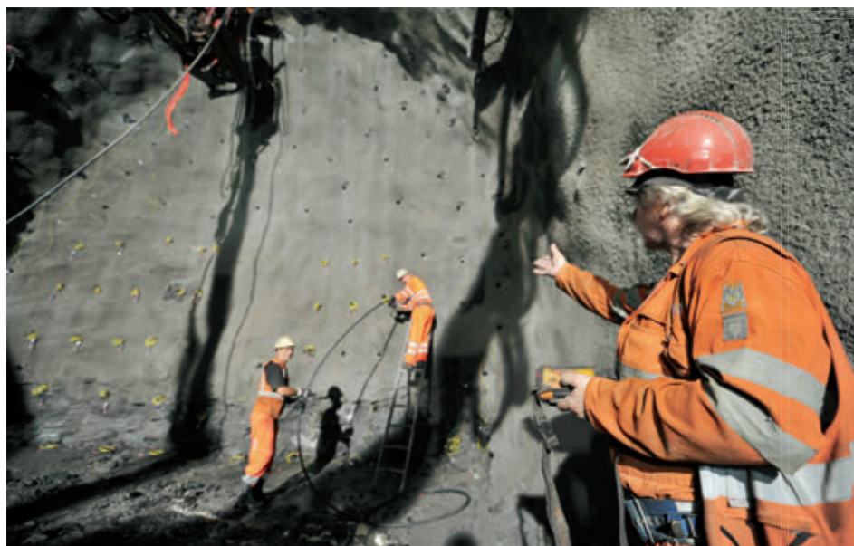
Operai al lavoro all'interno della galleria del Monte Ceneri
