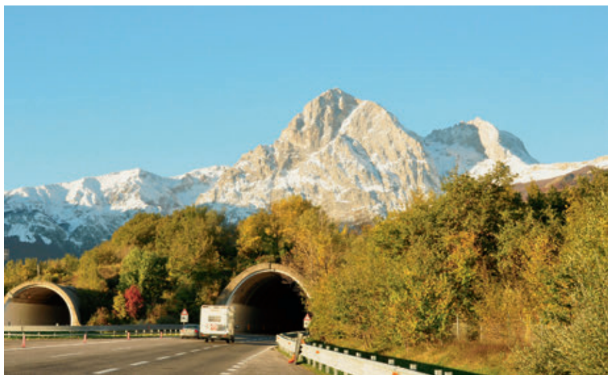
Una necessità della nostra rete autostradale, spesso disattesa, è di curarne la manutenzione, anche per i tanti viadotti e tunnel che la caratterizzano
