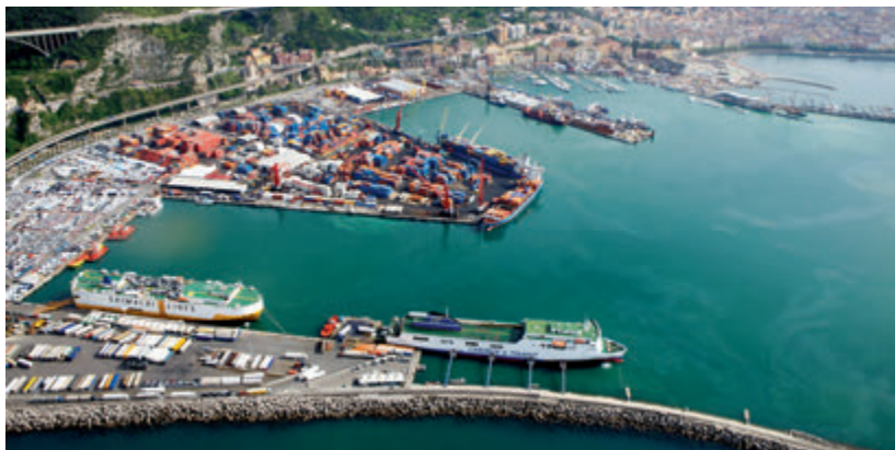
Veduta aerea del porto di Salerno. Lo scalo rientra nell'area della Zes campana con i porti di Napoli e Castellammare di Stabia e gli interporti di Nola e Marigliano
