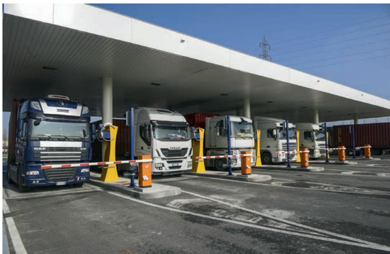
Tra gli interventi programmati c'è anche la totale automazione dell'entrata/uscita dall'interporto
