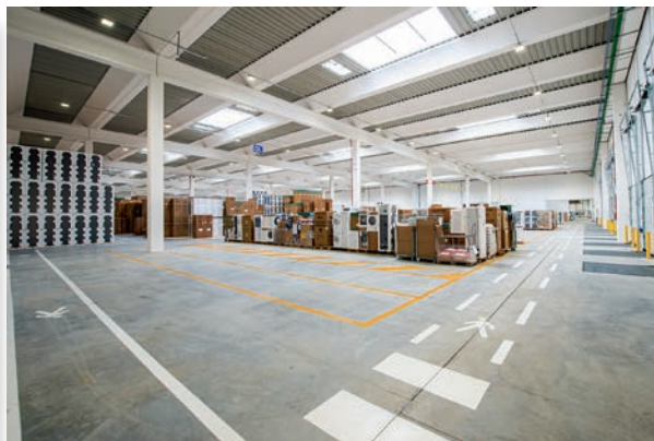
Due immagini del magazzino DIMO di Vercelli, realizzato dalla Kontractor
