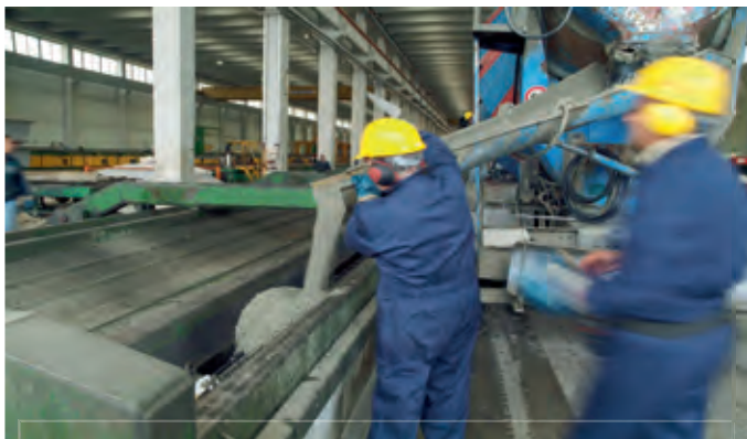
Una fase della produzione di elementi prefabbricati
