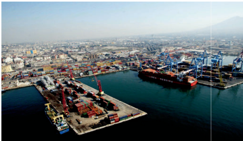
Veduta del porto di Napoli. Le Zes in Italia devono necessariamente comprendere un importante scalo marittimo, ciò per dare alle aziende che vi si insediano uno sbocco per l'export
