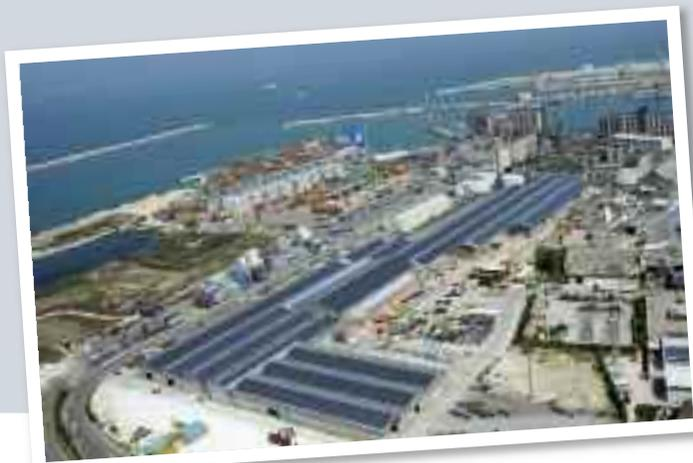
*In primo piano, il grande impianto fotovoltaico, in grado di produrre energia pari al fabbisogno di 1.600 famiglie*
